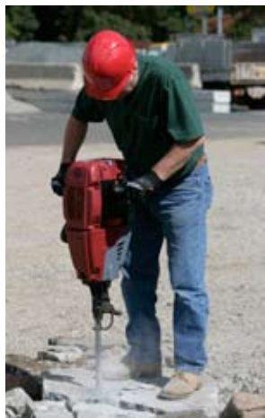
Spargerea betonului.
